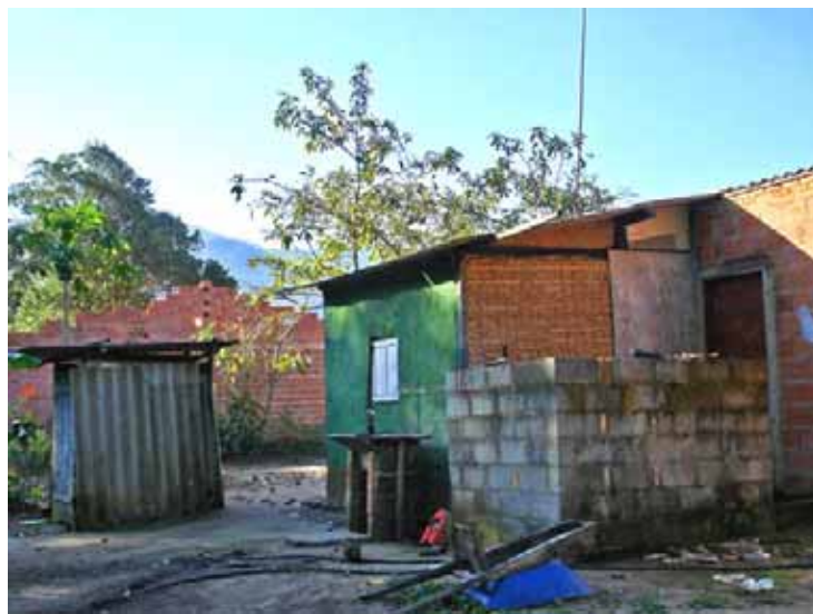
Foto 44 e 45. P. Noffs, 1996 e 2007. Há dez anos as casas eram de pau-a-pique, como essas no Canto da Lagoa. Atualmente o emprego da alvenaria é cada vez mais freqüente, tanto para novas casas, como para reformar as existentes.
