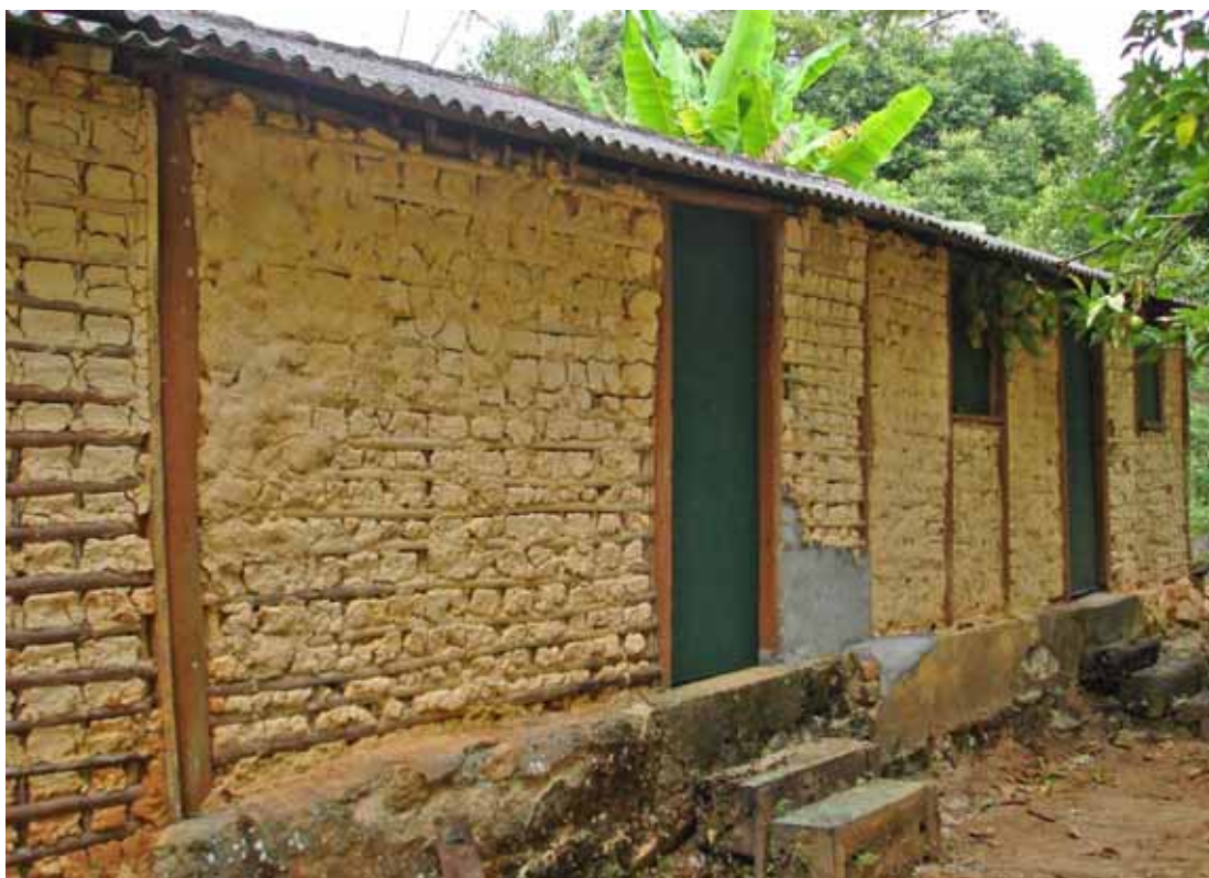
Foto 33. P. Noffs, 2007. Casa de turista no Saco do Sombrio comprada de caiçara e reformada mantendo suas características originais. Moradores locais informaram que ela está embargada, mas continua sendo utilizada. Há um caiçara do lugar contratado para realizar os serviços de manutenção e guarda da propriedade.
